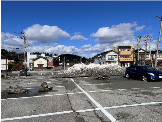
写真3 残雪に残された津波の痕跡
