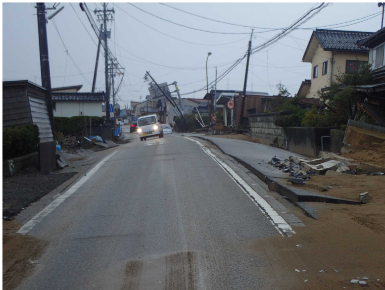
道路の被害状況（内灘町西荒屋地区）
